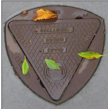
Fig. 10. Tapa de alcantarilla de San Francisco con forma de triángulo de Reuleaux
